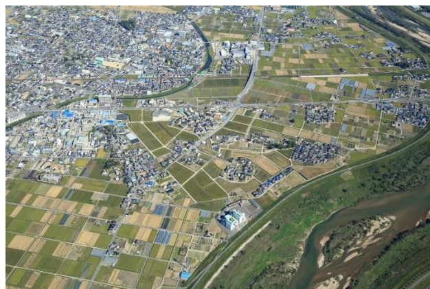
【ほ場整備完了後 東牧内工区】
