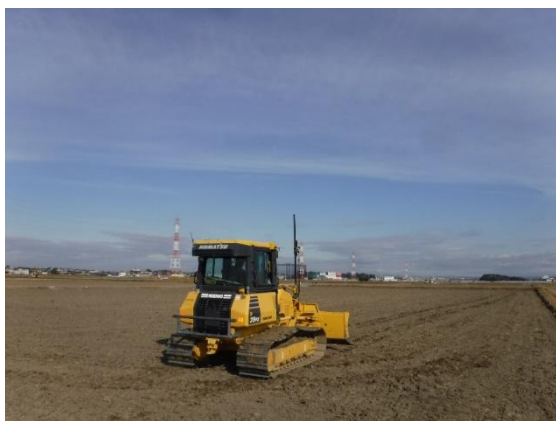
【ほ場整備工事】
