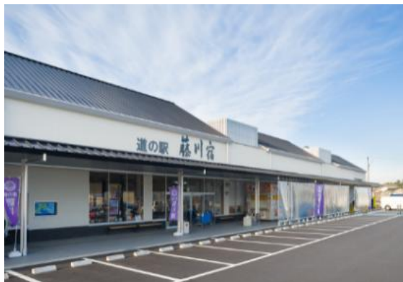
【道の駅藤川宿（藤川町）】 平成 24 年オープン
