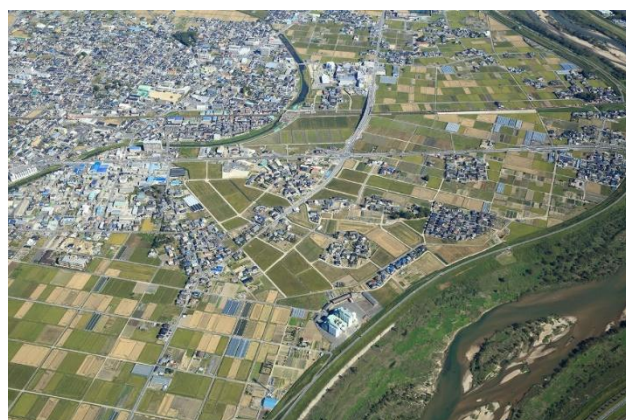
【ほ場整備完了後 東牧内工区】
