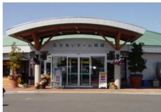
【ふれあいドーム岡崎（下青野町） 平成12年オープン
