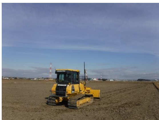
【ほ場整備工事】
