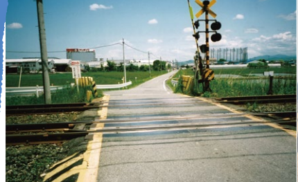
牧内跨線橋建設前の東海道本線東牧内踏切（平成17年）
