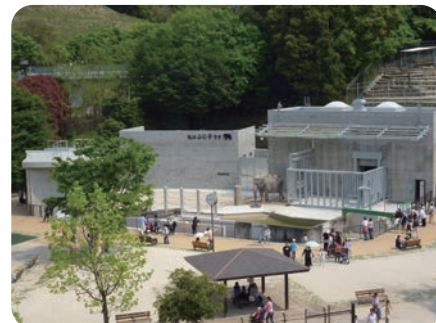
新ゾウ舎完成後の写真
