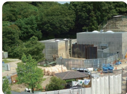
工事中の写真
