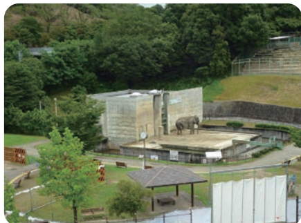
工事が始まる前の写真（旧ゾウ舎）
