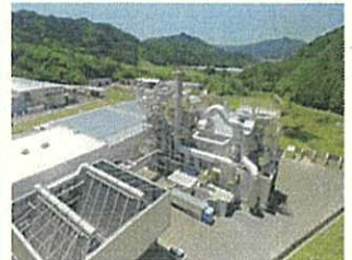
バイオマス発電施設（真庭市）
