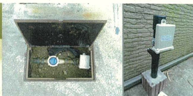
水道メータの設置施工例
