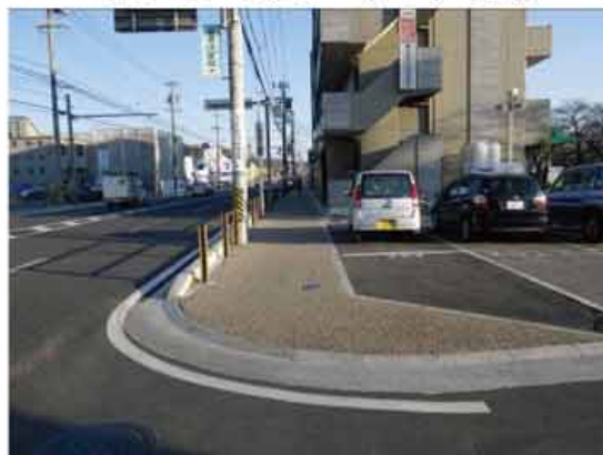
図2-11 歩道のバリアフリー整備
