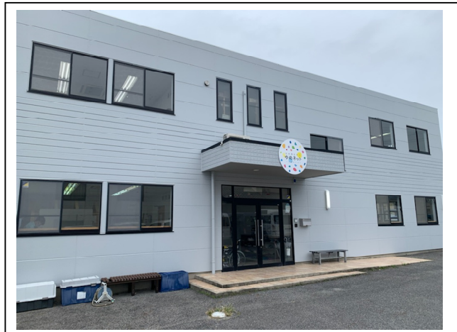
【S-tep ステラⅡ 外観】
