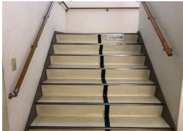
【 階段(手すり付き) 】
