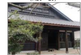
図3：旧富田家住宅(主屋)修理・修景(H30)
