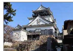
図1：天守台石垣前樹木伐採(R5)
