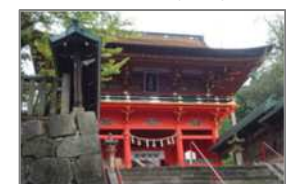
図2：六所神社社殿の塗替補修(H26～29)
