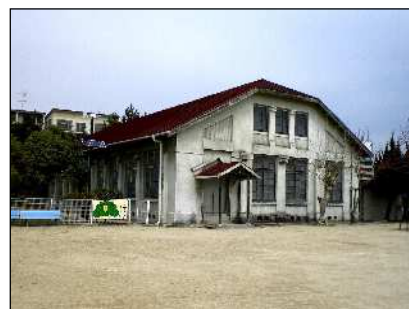
図1-5-47 旧愛知県岡崎師範学校武道場
