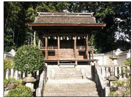
図1-5-18 土呂八幡宮本殿
