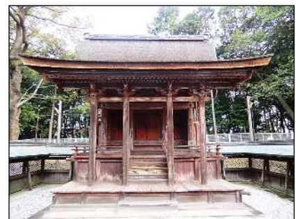
図1-5-16 上地八幡宮本殿
