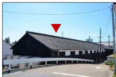
図2-5-6 ②新甲子蔵 (昭和14年(1939)建築)
