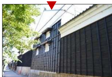
図2-5-9 ⑥大黒蔵 (明治7年(1874)建築)
