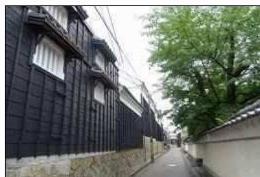
図2-5-13 ②～⑨八丁蔵通りの全景
