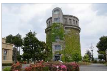
図4-3-19 六供配水場配水塔
