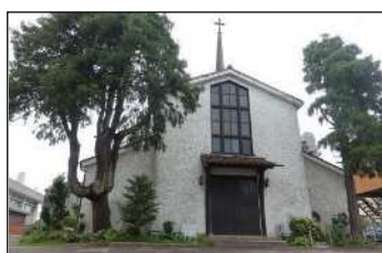
図4-3-28 日本福音ルーテル岡崎教会教会堂
