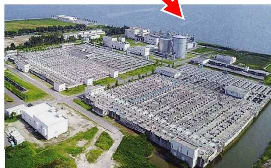
▲矢作川浄化センター(平成4年処理開始：西尾)
