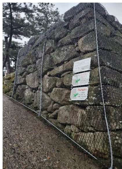
【石垣保護ネットの設置】
