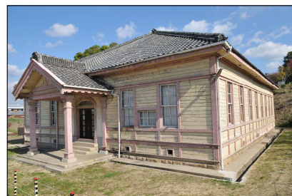
図1-5-46 旧愛知県第二尋常中学校講堂
