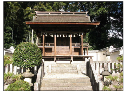
図1-5-18 土呂八幡宮本殿
