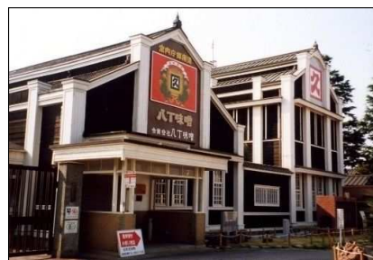
図1-5-41 八丁味噌本社事務所
