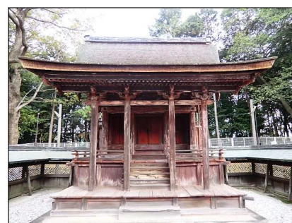
図1-5-16 上地八幡宮本殿
