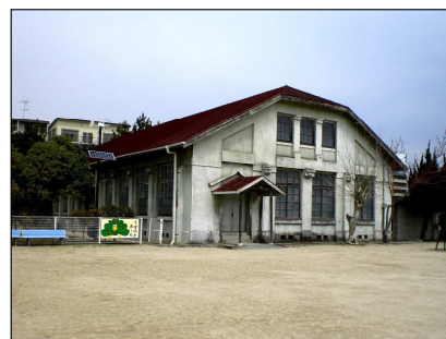
図1-5-47 旧愛知県岡崎師範学校武道場
