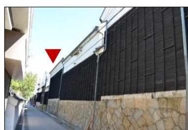
図2-5-10 ⑦乾蔵 (明治7年(1874)建築)
