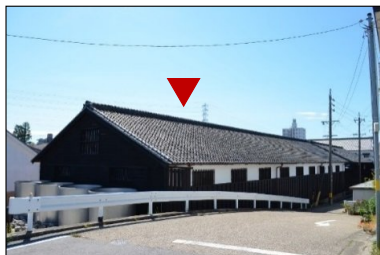
図2-5-6 ②新甲子蔵 (昭和14年(1939)建築)
