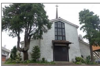
図4-3-28 日本福音ルーテル岡崎教会教会堂
