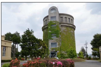
図4-3-19 六供配水場配水塔
