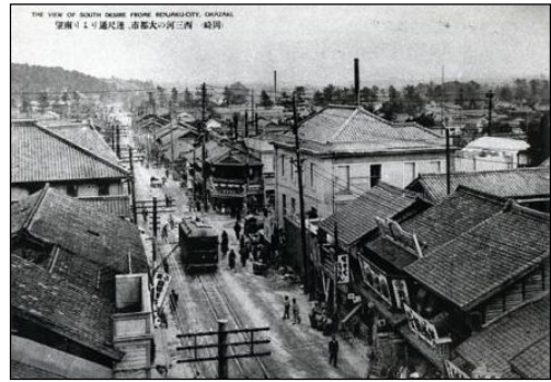
図1-19 岡崎市内線(岡崎電気軌道(民営))
