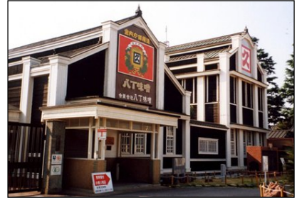
図2-9 カクキュー本社事務所
