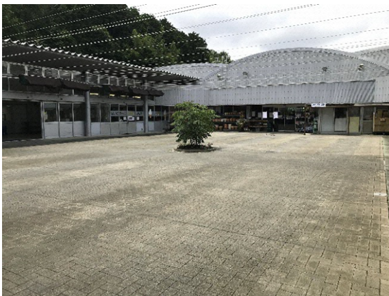
【多目的広場】部分的な舗装面などに汚れやいたみ、舗装ブロックの撓みなどみられる
