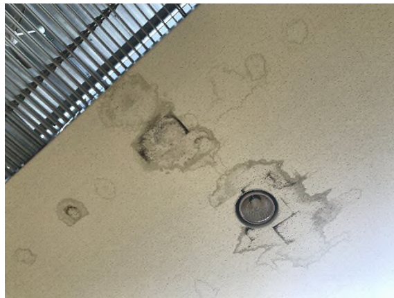
【内部仕上】壁のひび割れ、天井の雨漏りなどがあり部分的に劣化が進行
