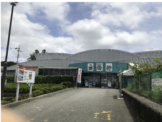
【外構など】舗装面などに部分的な汚れやいたみ、アスファルトの撓みなどがみられる
