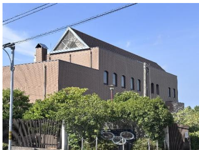
①吹矢汚水中継ポンプ場
