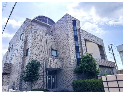
②大西汚水中継ポンプ場
