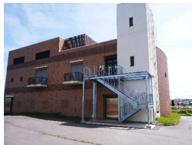
③美合汚水中継ポンプ場
