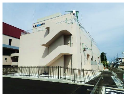
③六名雨水ポンプ場
