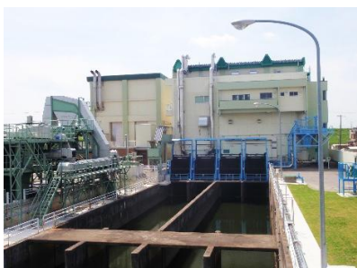
①大門雨水ポンプ場
