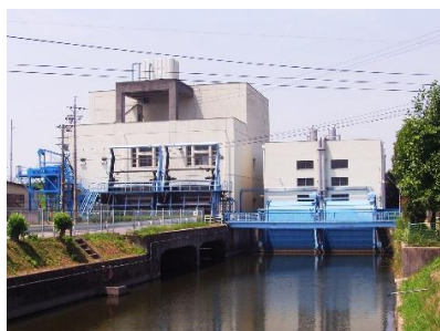
②八帖雨水ポンプ場
