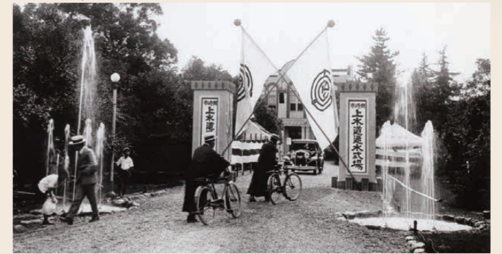
▲昭和8年 上水道通水式
