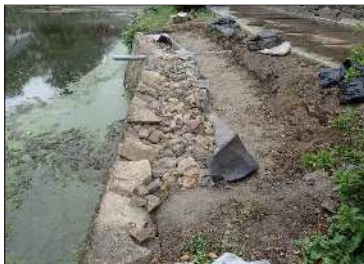
写真2 石垣積み直し状況
