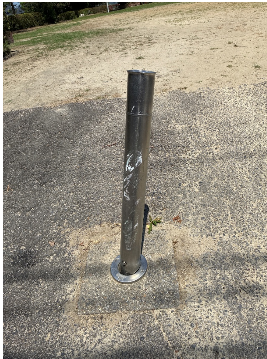
車止め被害状況（拡大）
