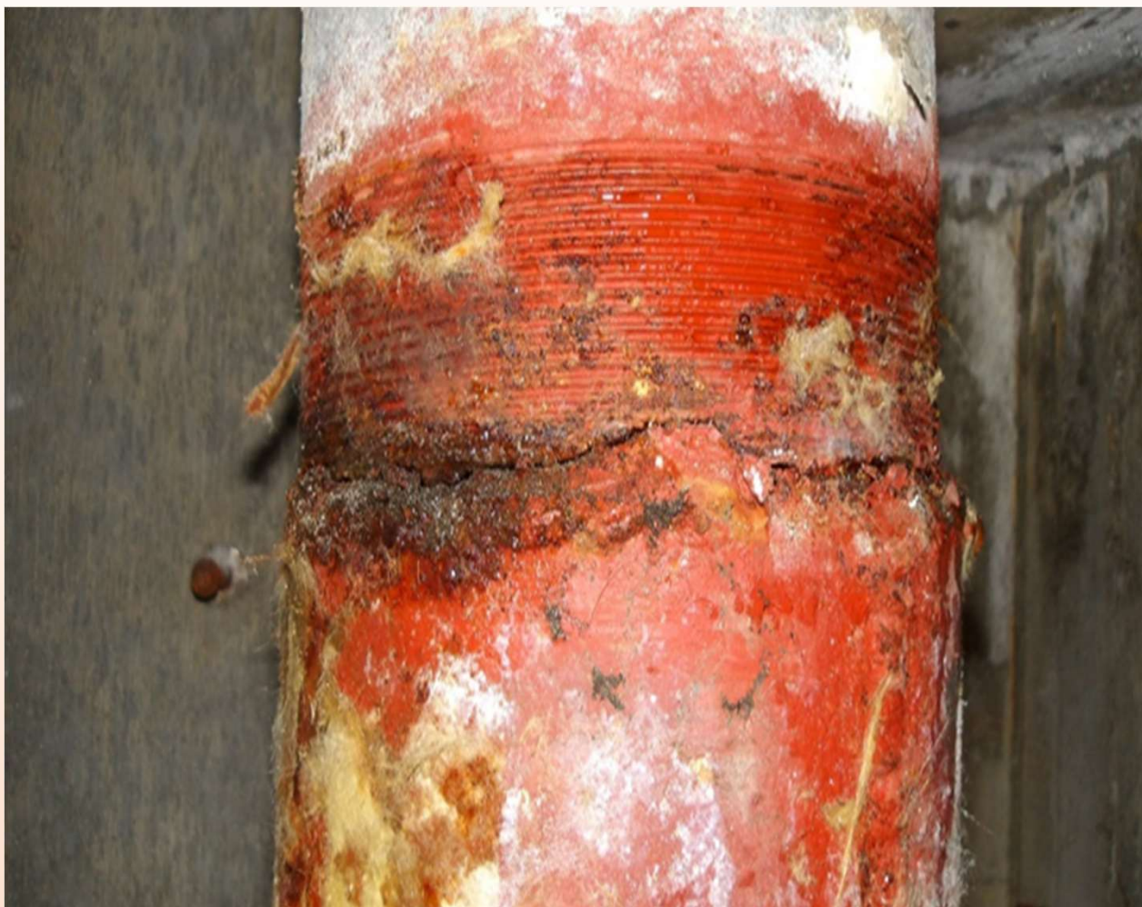
本館棟西階段内部排水管腐食状況
