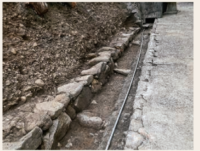
▲発掘された野面積石垣と石階段(南から)
