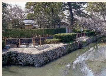
▲龍城堀南面に設置した展望デッキ
