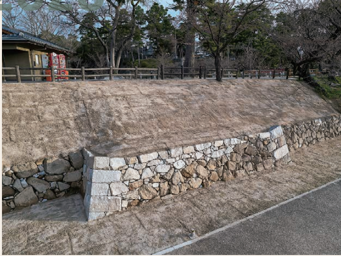
▲工事が完了した菅生川端石垣西柵形(南西から)
