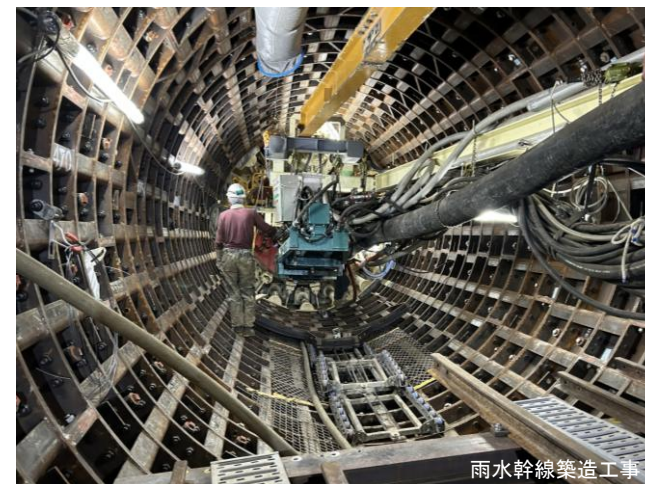
雨水幹線築造工事
