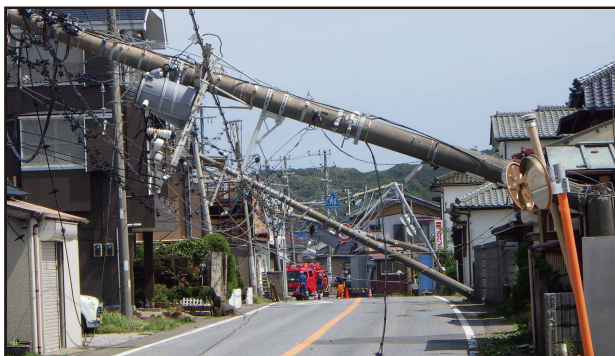
【平成30年9月 台風第21号 大阪府泉南市(市道：樽井大苗代新家線)】 大阪府を中心に1,000本以上の電柱が倒壊 ※国土交通省調べ
