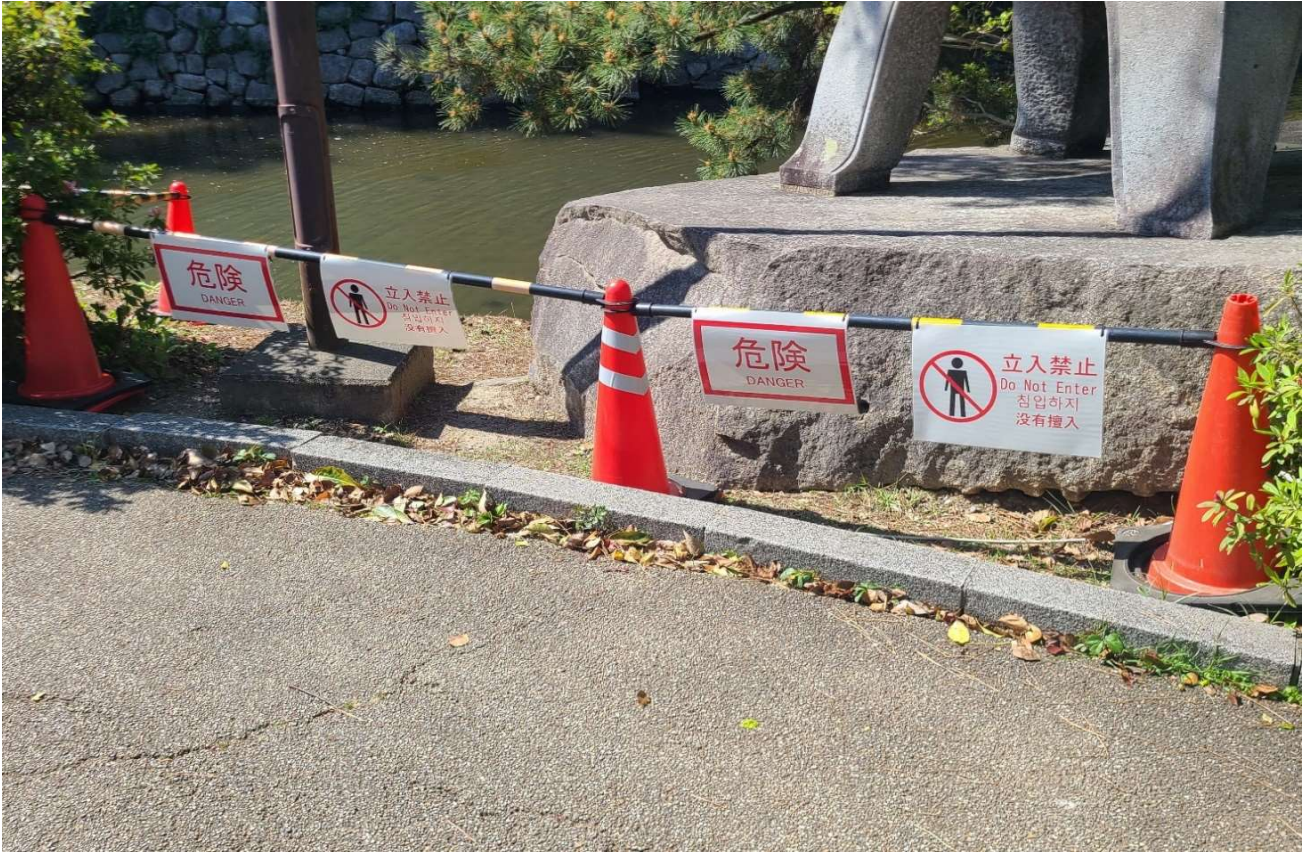
写真3 立入禁止措置
