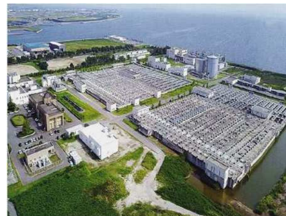
矢作川浄化センター(西尾市港町1)全景 三河湾に面した一級河川矢作川の左岸河口に位置し、敷地面積62.5haはナゴヤドーム13個分
