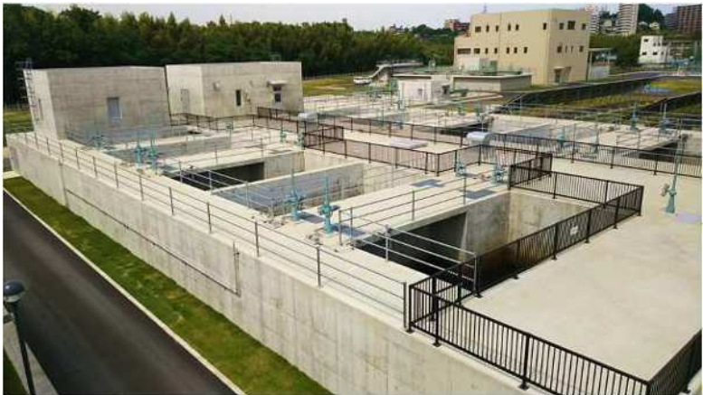
男川浄水場 急速ろ過池
