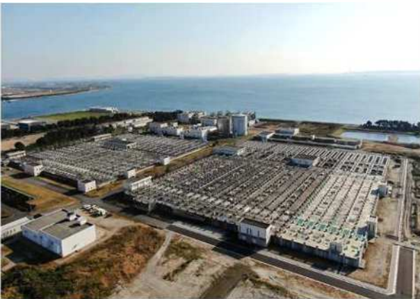
矢作川浄化センター（西尾市港町1）
