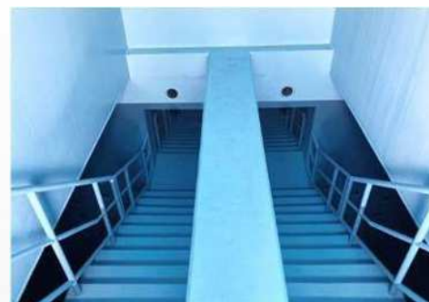
北野配水場受水槽 塗装工事
