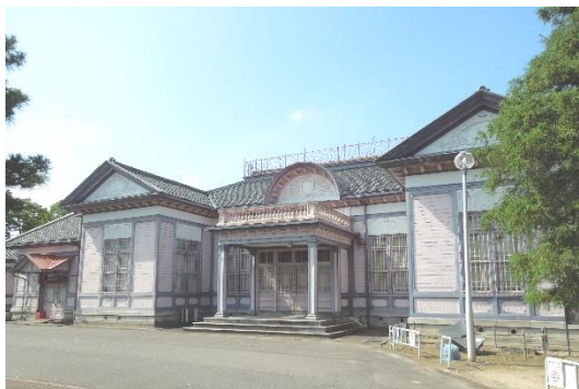
旧額田郡公会堂（大正 2 年建設）
