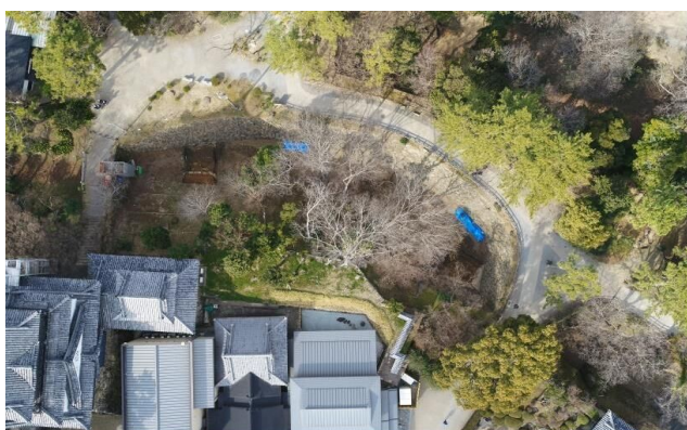
清海堀全景（俯瞰）
