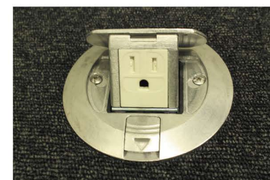
床埋め込みコンセント（開）
