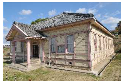
図1-5-46 旧愛知県第二尋常中学校講堂
