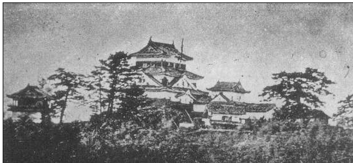
図1-3-34 旧岡崎城天守(明治5年(1872)、南東方向より)
