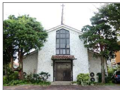
図1-5-48 日本福音ルーテル岡崎教会教会堂
