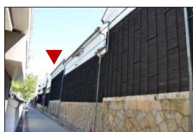
図2-5-10 ⑦乾蔵 (明治7年(1874)建築)
