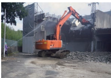
解体中の旧男川浄水場
