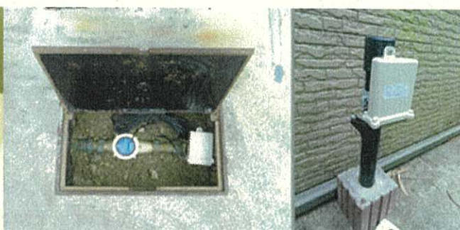
水道メーターの設置施工例
