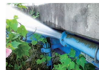
▲老朽化した水道管の漏水の様子
