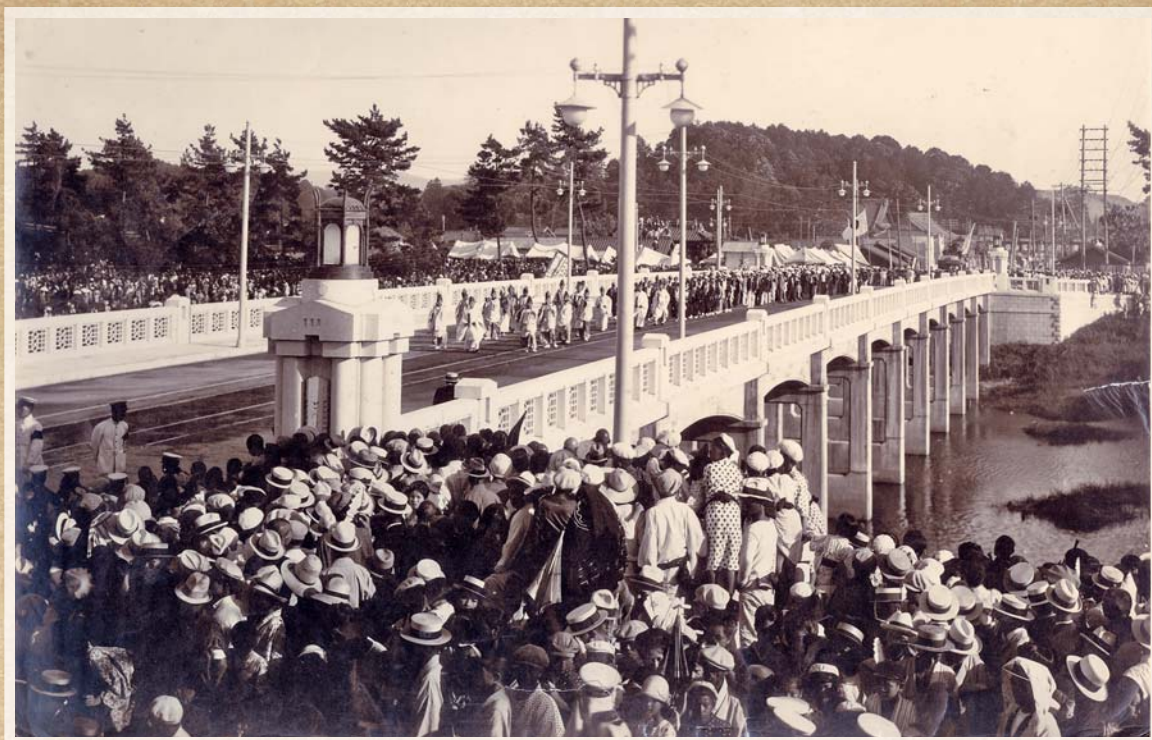
▲殿橋渡り初め（昭和2年）北から南をのぞむ
