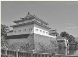
▲駿府城築櫓（静岡市葵区）
