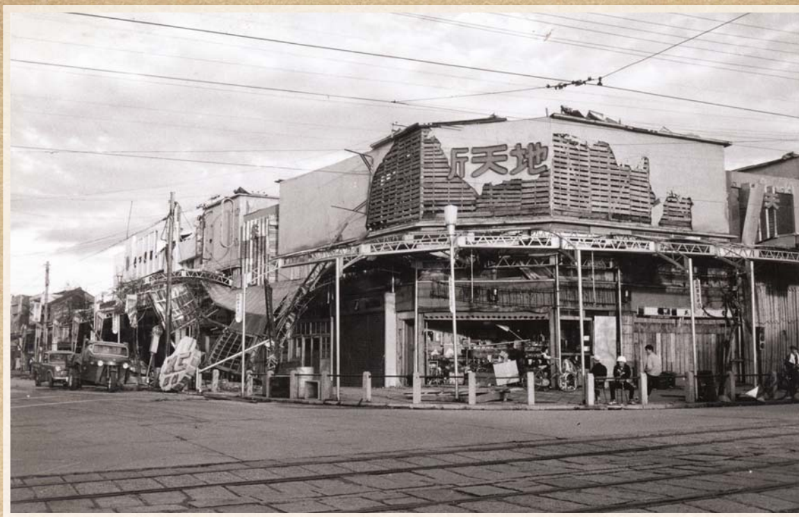
▲被害を受けた康生北交差点の商店街「新天地」
