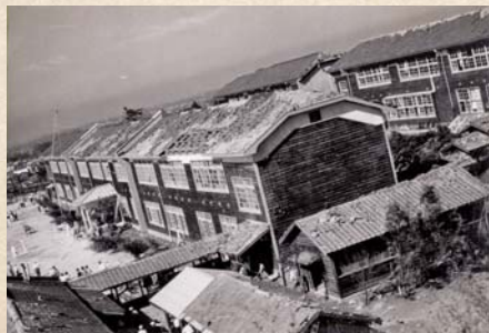
▲屋根瓦が飛ばされた甲山中学校
